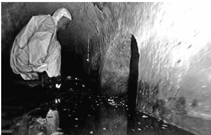
Robotnik usuwa z kanału kostki brukowe i deski blokujące przepływ ścieków.
