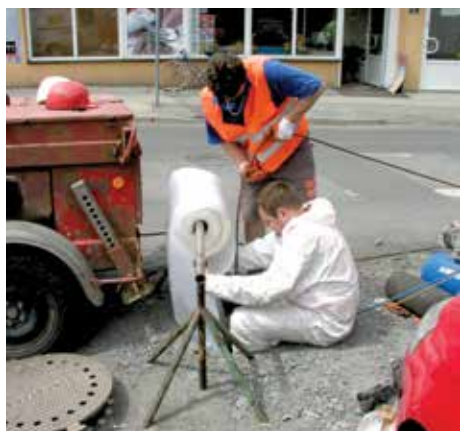
Wprowadzanie do rur folii ochronnej, po której wprowadzany jest specjalny rękaw.
