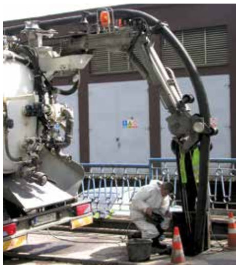
Czyszczenie wodą pod dużym ciśnieniem istniejącej kanalizacji.
