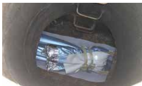
Widok przez studzienkę kanalizacyjną: przeciągnięcie rękawa przez kanał po folii ochronnej.
