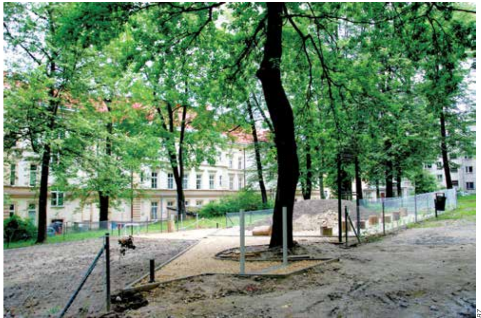
Koniec czerwca - trwają prace nad przygotowaniem terenu w Parku Kasztanowym. Plac zabaw powinien być gotowy w drugiej połowie lipca.
