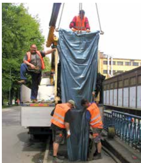
Wprowadzanie do kanalizacji specjalnego, żywicznego rękawa.
